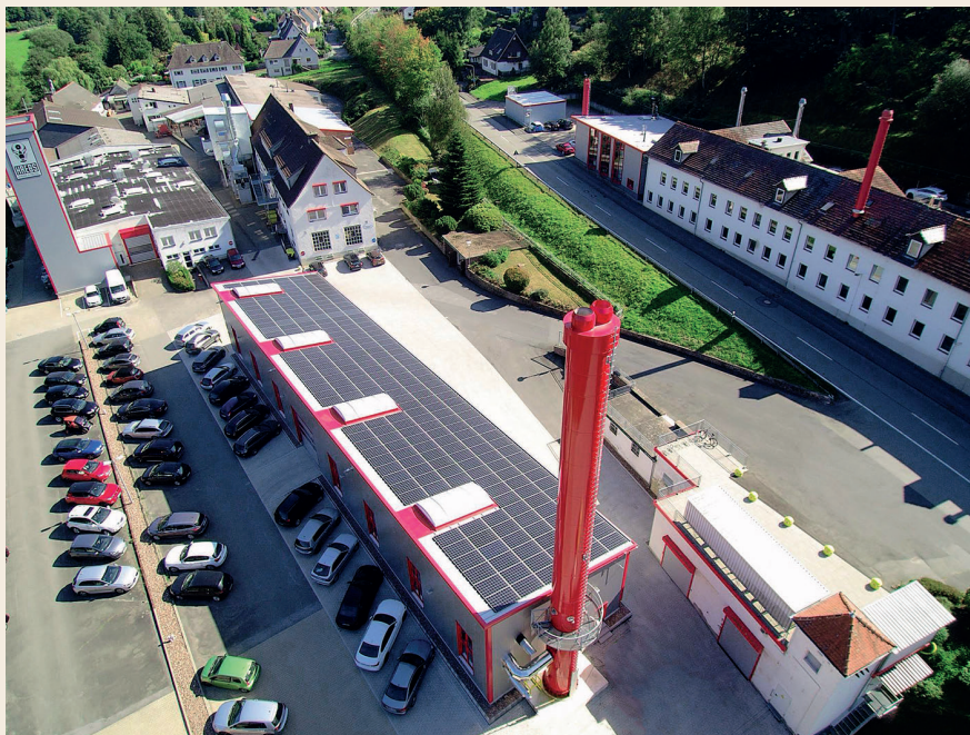
Bild 1. Der Standort der Schleifscheibenfabrik in Bad Karlshafen wird permanent ausgebaut. Bild: Krebs & Riedel
